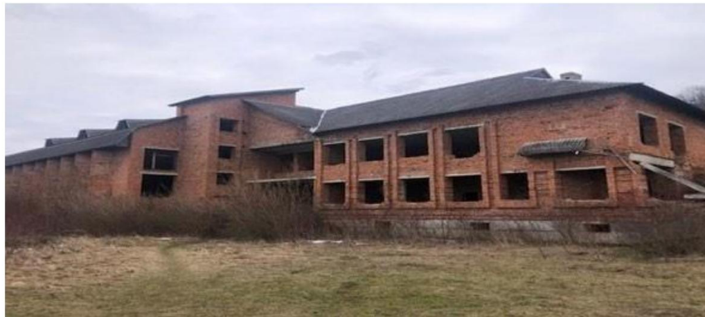
Малюнок 2: Поточна ситуація будівництва в Розгирчі
